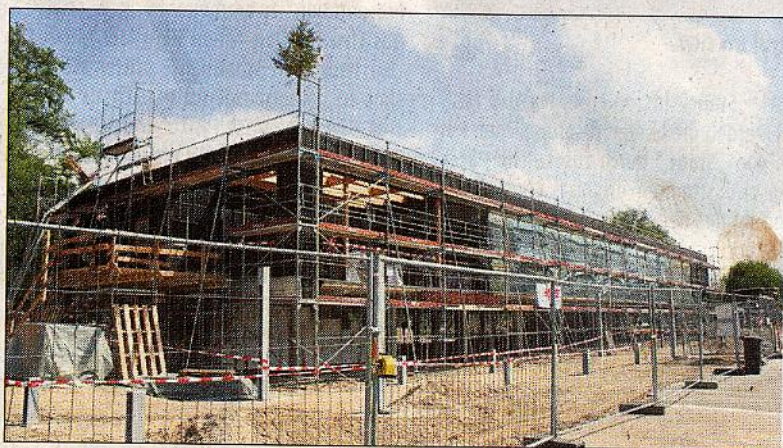
Nach vier Monaten Bauzeit konnte schon Richtfest gefeiert werden.
